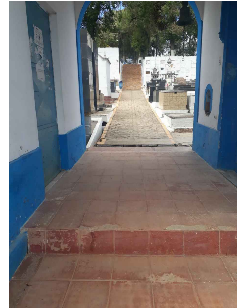
FOTO 02 - EDIFICAÇÃO DA ENTRADA
